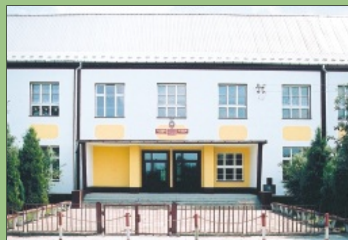
Nowa elewacja szkoły w Szczurowej.
