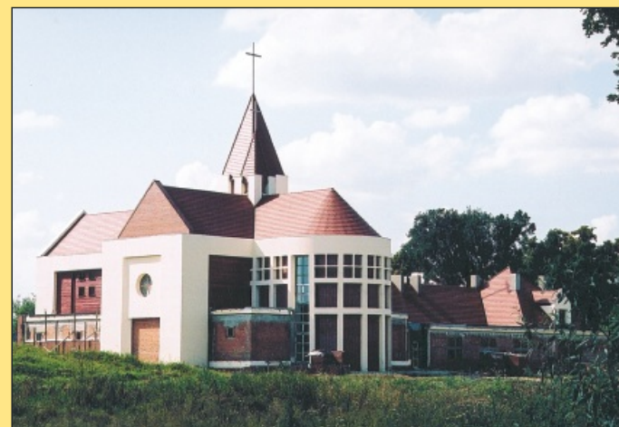
Nowo budowany kościół w Strzelcach Wielkich
