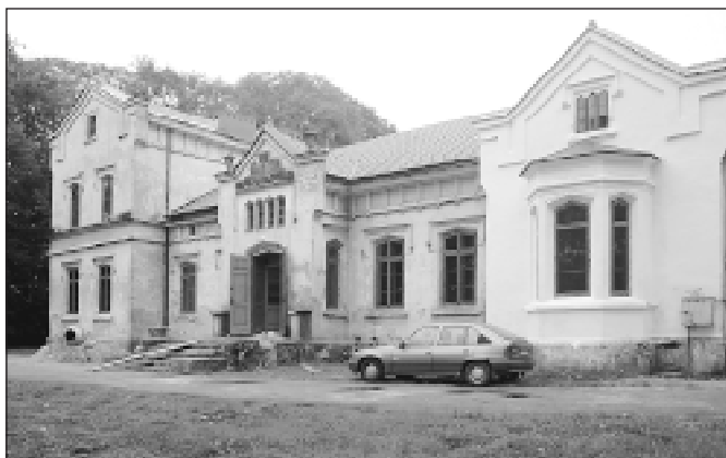
Trwa generalny remont dworku.
