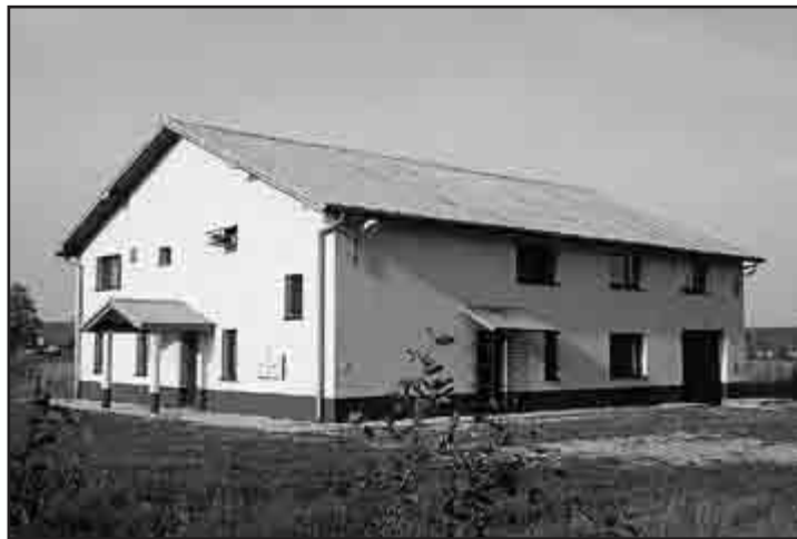
Budynek w Rudy-Rysiu po termomodernizacji.
