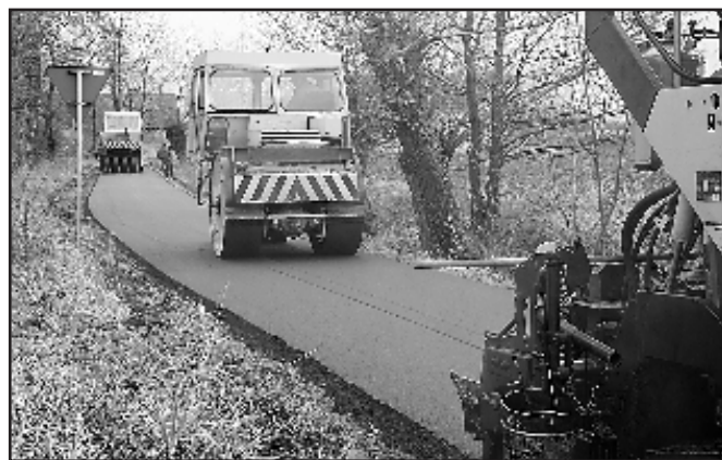
Budowa nowej nawierzchni w Szczurowej-Zakręciu.
