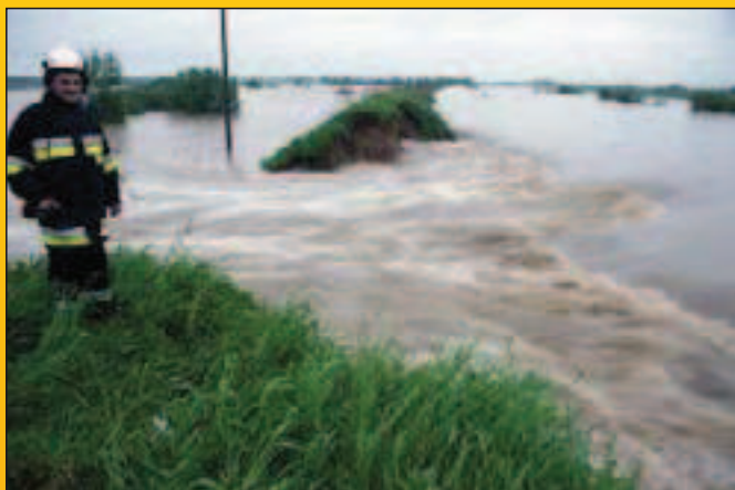
Kwików – pierwsza wyrwa w wale Uszwicy.
