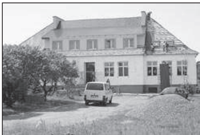
Budynek szkoły w Rudy-Rysiu w trakcie remontu.
