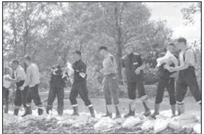
Strażacy uszczelniający wyrwę w Księżych Kopaczach.
