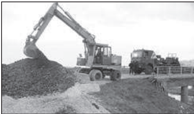
Budowa drogi wzdłuż wału do miejsca wyrwy w Księżych Kopaczach.
