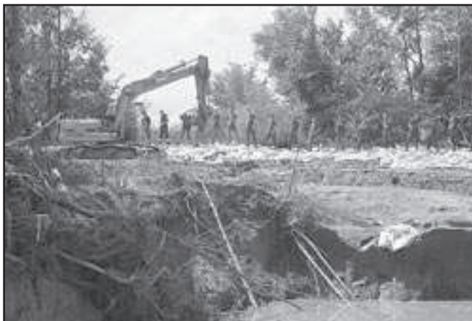
Księżę Kopacze. Zabezpieczanie wyrwy w wale.
