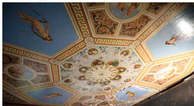
Efekt prac renowacyjnych polichromii w dworze Kępińskich w Szczurowej
