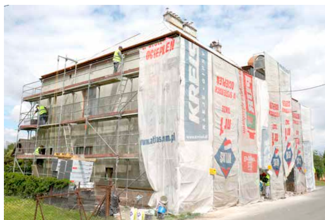
Budynek Domu Ludowego w trakcie rozpoczętych prac remontowych
