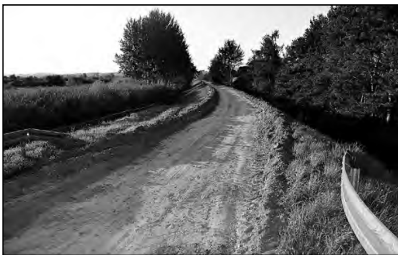
Ścieżka rowerowa na wałach Raby w Uściu Solnym w trakcie budowy
