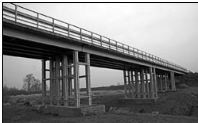
Wyremontowany most w Kopaczach Wielkich.
