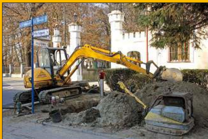
Szczurowa. Modernizacja wodociągu.
