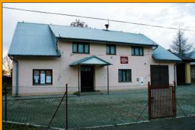
Górka. Remontowana remiza OSP.
