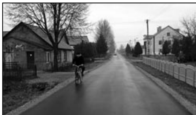
Nowa nawierzchnia w centrum Dołęgi.
