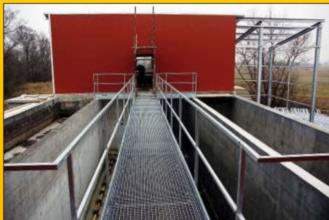
Szczurowa. Rozbudowa oczyszczalni ścieków.
