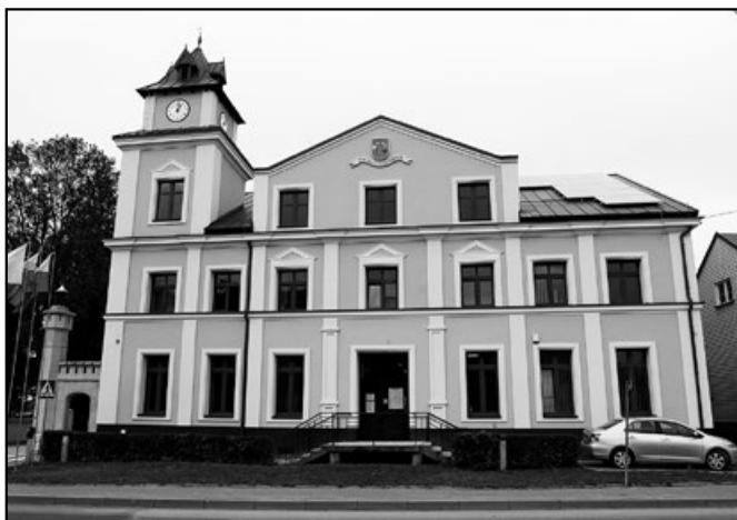
Budynek Urzędu Gminy
