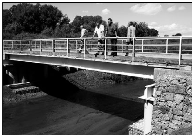
Wyremontowany most na Uszwicy
