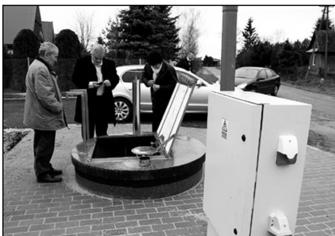
Odbiór techniczny studni w Szczurowej-Włoszynie
